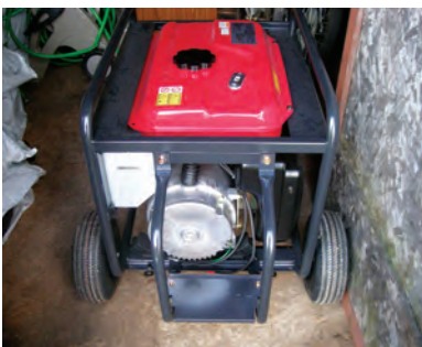
Une génératrice peut faire fonctionner une pompe d'assèchement et d'autres appareils électriques pendant une panne d'électricité.
