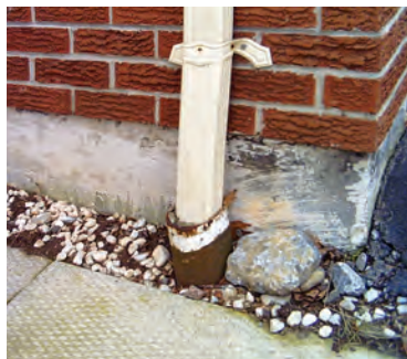
Ces descentes pluviales sont raccordées au réseau souterrain d'égout municipal.
