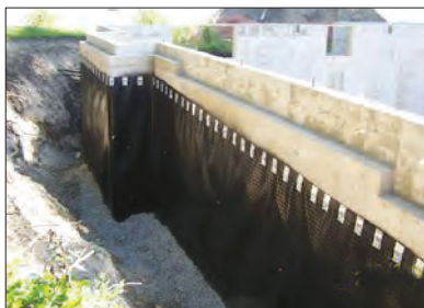
Vide autour des murs de fondation d'une maison en construction
