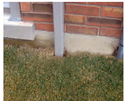
Ces descentes pluviales sont raccordées au réseau souterrain d'égout municipal.
